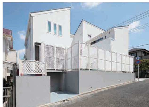
プライバシーに配慮したラティスフェンスと 半地下構造を利用したもう1ヶ所の入口。
