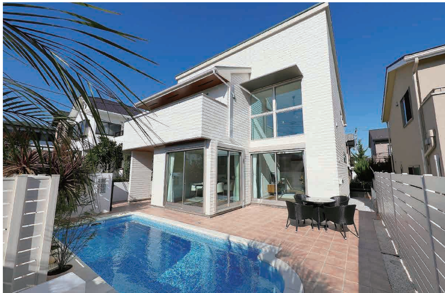
吹き抜けのある都市型プールハウス
